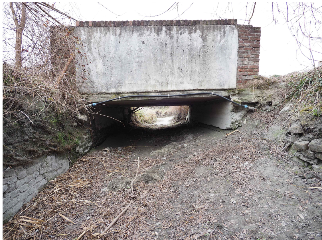
Fondazioni della spalla del ponte interno alveo da proteggere con getti di ripristino e armature
