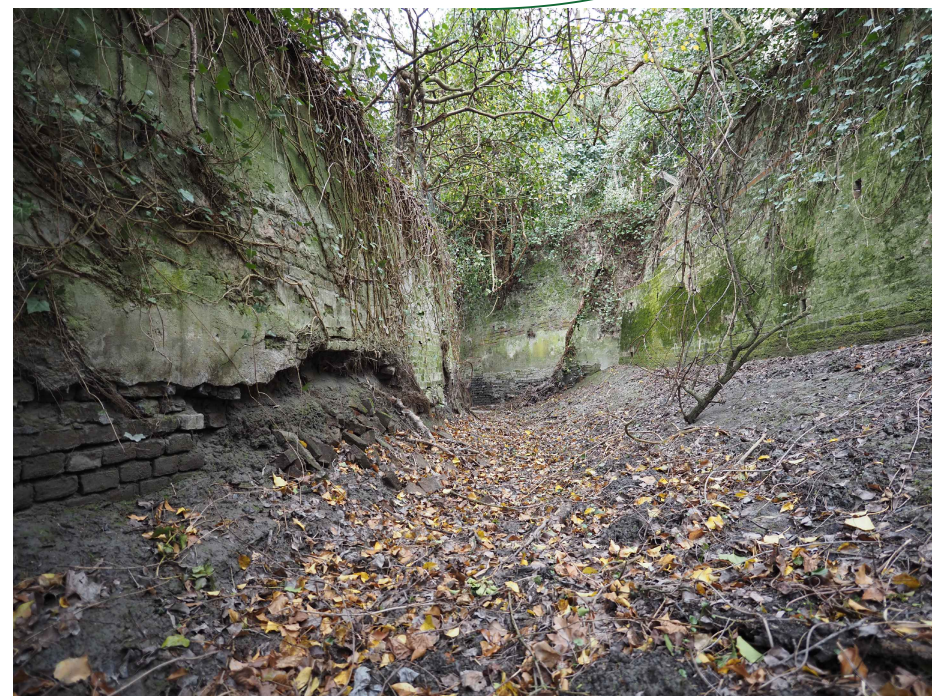
Proteggere il basso alveo riempiendo i buchi con mattoni e rivestimento del paramento con malte a tenuta idraulica
