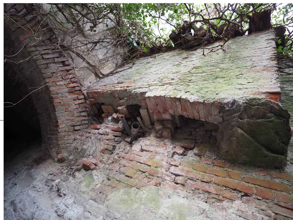
Cucì e scuci e ripristino con barre chimicate inserire modiglione in acciaio a sostegno di quello in pietra in via di sfaldamento
