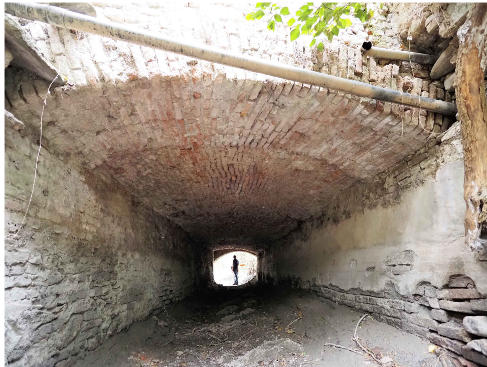
Stilatura dei letti di malta di calce al fine di fermare i mattoni che iniziano a muovere e la malta a sfarinare
